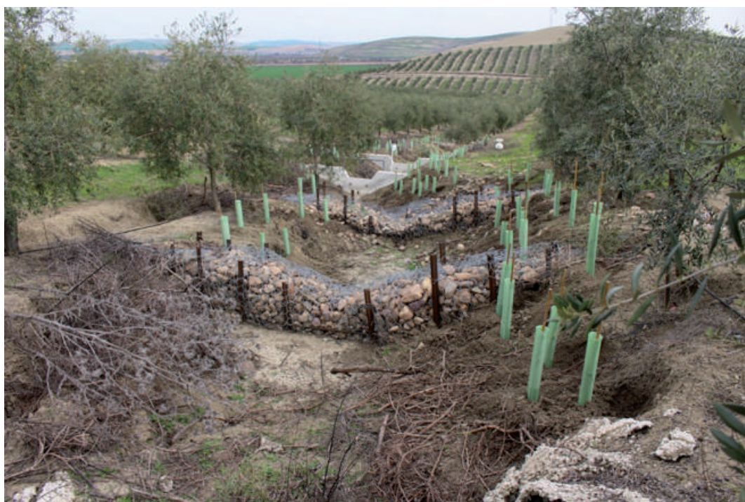
Figura 3.2.8.4. Conjunto de varios diques de contención con diferentes diseños en un olivar del sur de España (Foto J.A. Gómez).
