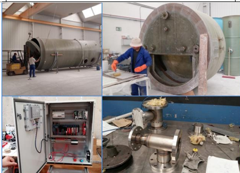
Figura 15. Visita a la ejecución de los depósitos de hidrólisis, montaje del cuadro eléctrico y de control y ejecución de la instalación hidráulica.
