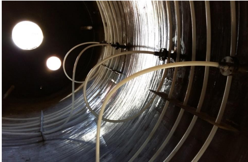
Figura 16. Instalación de los serpentines del sistema de calefacción en el interior del digestor.
