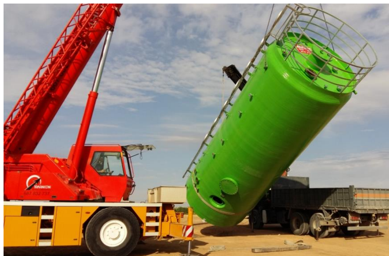
Figura 17. Izado del depósito que incluye reactor de hidrólisis II y el digestor.
