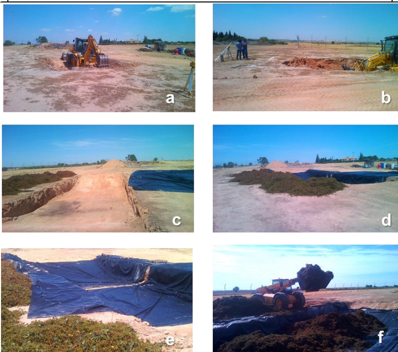
Figura 26. Labores de preparación de silo de dimensiones 14x6x1m (4/8/2015), colocación de la cubierta de plástico y primer acopio de residuos de la bodega (28/08/2015).
